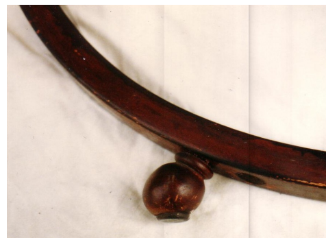
Abb. 7 und 8 Rasten zur Einstellung der Rückenlehne und Kufenstütze mit zweitem Dübelloch
